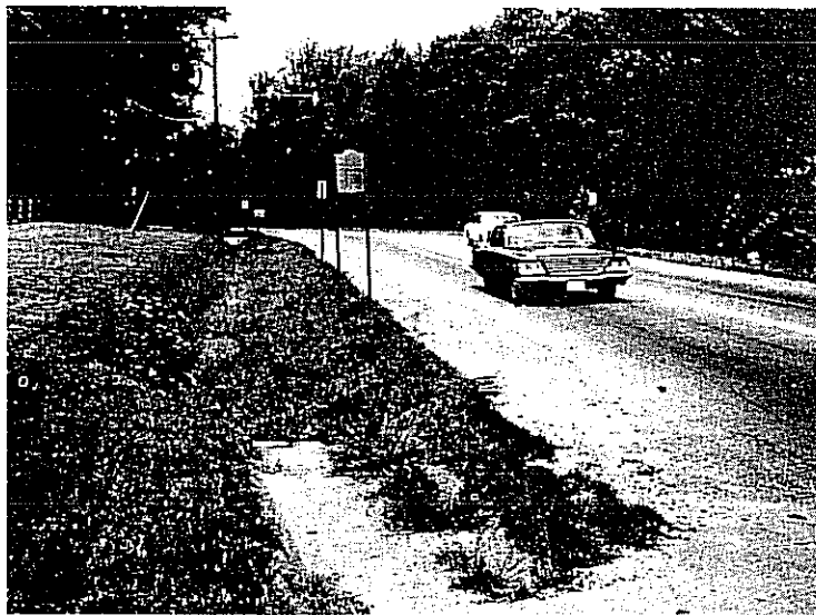
Figura 2. Cunetas laterales que ayudan la eliminación del agua superficial y el drenaje de la capa base
