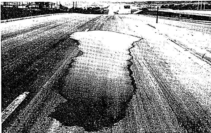
Figura 18. Depresión. El área deprimida se nota por el depósito de agua en el pavimento
