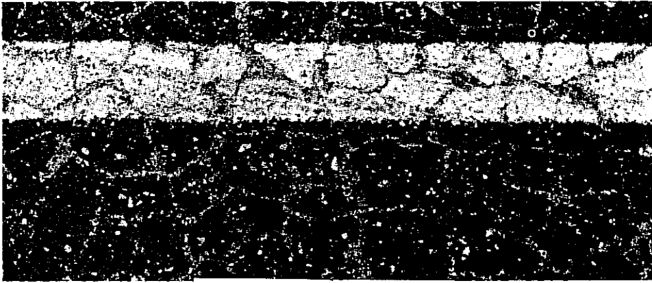
Figura 7. Fisuras piel de cocodrilo
