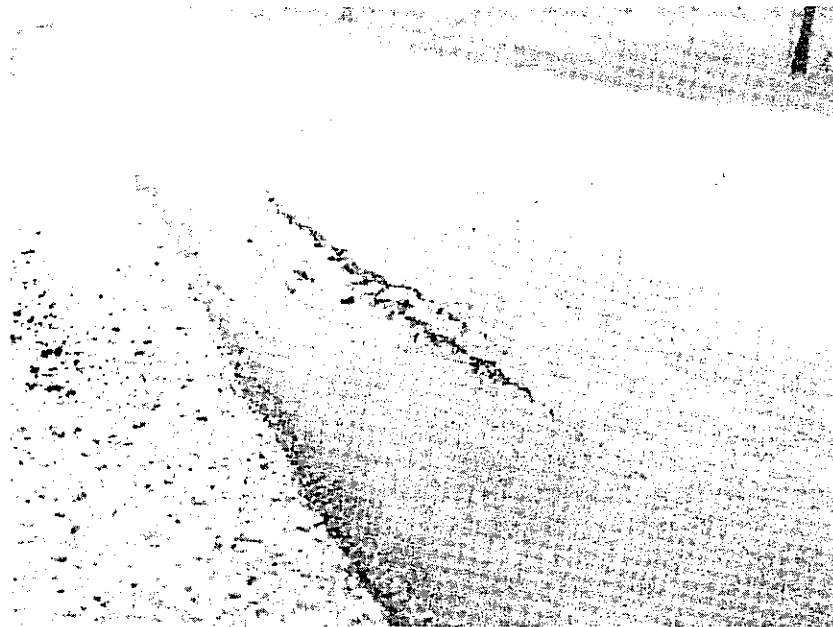
Figura 8. Fisura de borde (Foto cortesía de Ohio Highway Dept.)
