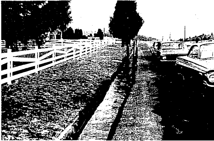
Figura 3. Las cunetas laterales pavimentadas no se erosionan
