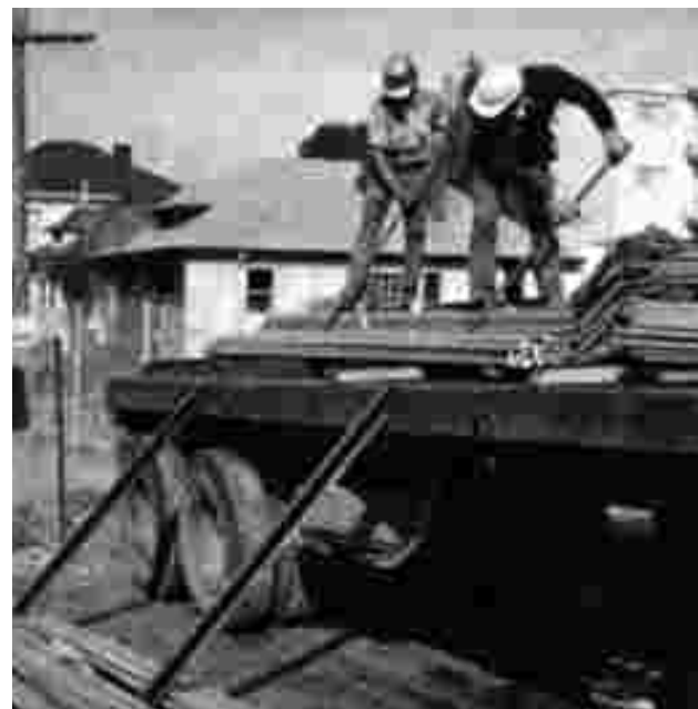
Descarga manual del acero desde camión.
