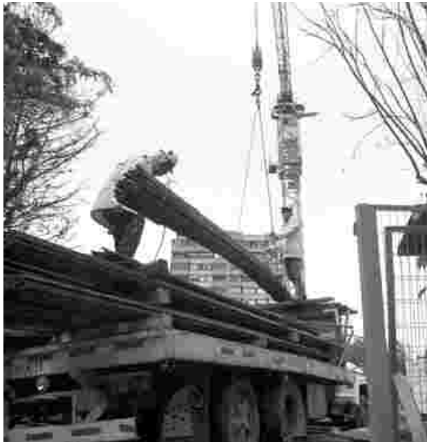
Carga ó descarga del acero desde un camión mediante grúa
