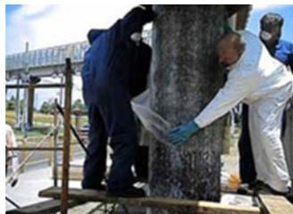
Los sistemas TYFO<sup>®</sup>, son un sistema de refuerzo estructural que consiste en fibras vidrio que se impregnan con resinas de alta calidad para formar un laminado que se adhiere externamente al elemento que será reforzado.
