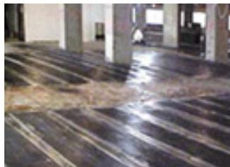
Los sistemas TYFO®, son un sistema de refuerzo estructural que consiste en fibras de carbono que se impregnan con resinas de alta calidad para formar un laminado que se adhiere externamente al elemento que será reforzado.
