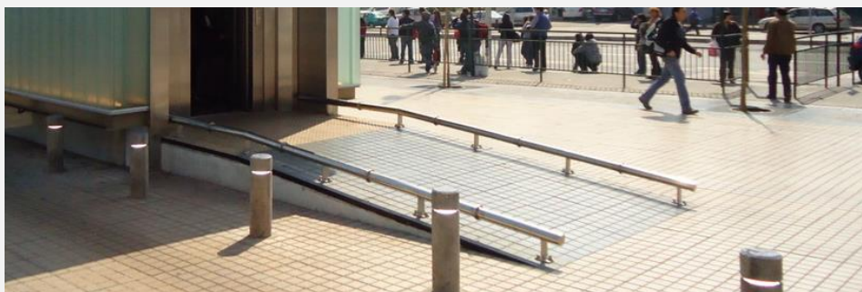
Foto 52: Rampa con protección lateral.
