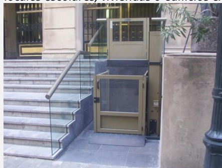
Foto 64 y 65: Modelos de plataformas elevadoras verticales para salvar desniveles en edificios existentes. Máximo 1,5m de desnivel.
