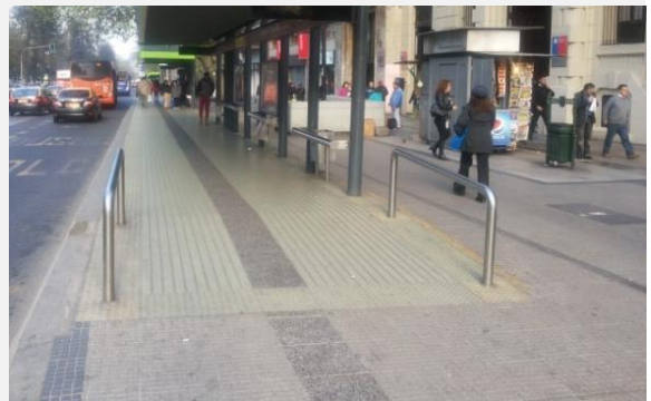
Foto 23: Paradero conectado a vereda mediante rampa..
