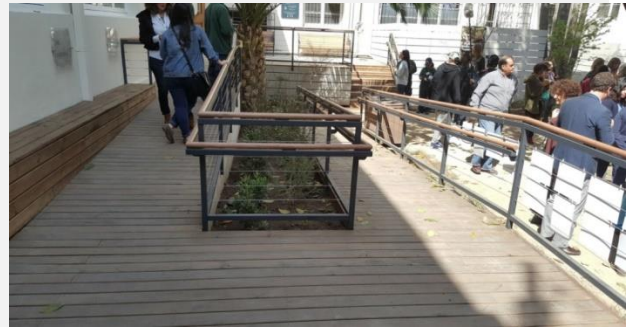
Foto 50: Rampa en "U" con giro en espacio plano.
