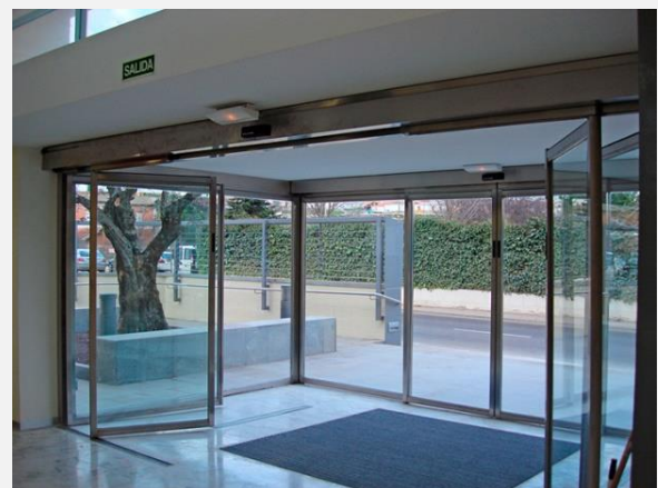
Foto 66: Acceso con doble puerta automáticas y espacio libre entre ellas.
