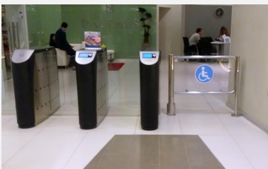
Foto 68 y 69: Control de acceso alternativo accesible a la entrada general por torniquetes.
