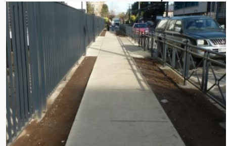
Foto 2: Vereda sin obstáculos y de pavimento estable, que conforma una ruta accesible en todo su ancho.
