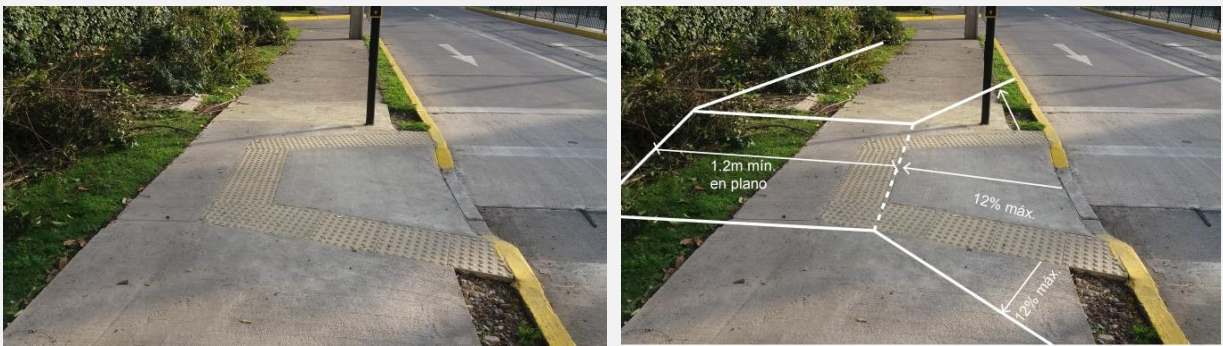
Foto 11 y 12: Ejemplo de cruce adicionando espacio de la acera para incorporar el 1,2m adicionales en plano que se requieren después del cruce.
