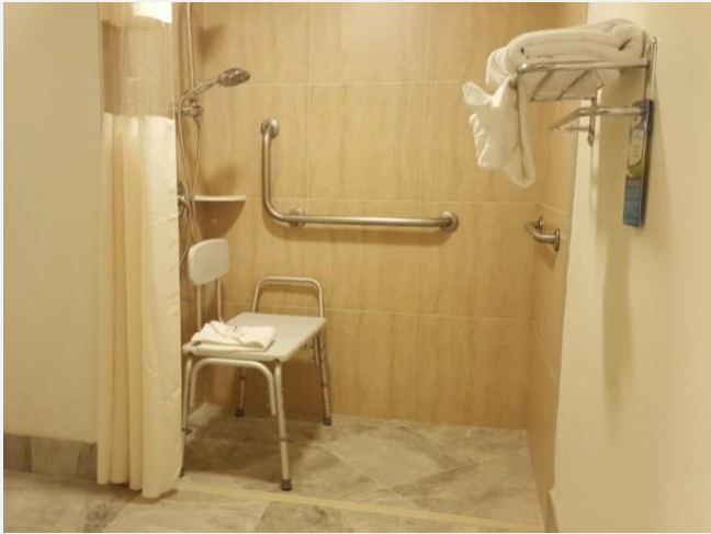
Foto 72: Ducha a nivel en baño con silla de transferencia regulable en altura y posición. Este modelo de silla de ducha se adapta a variadas condiciones de uso.
