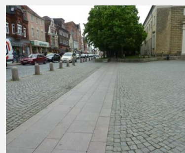
Foto 42: El pavimento irregular del entorno hace necesario un cambio de pavimento más estable en el ancho de la ruta accesible.
