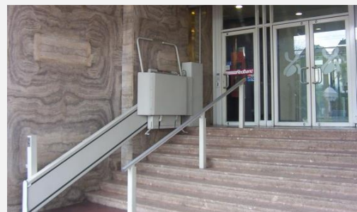
Foto 62 y 63: Modelos de plataformas elevadoras inclinadas para edificios existentes locales escolares, viviendas o edificios existentes destinados a servicios.
