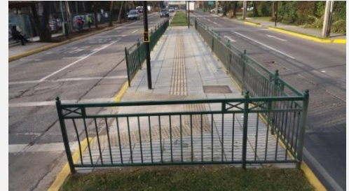
Fig 11: Mediana de ancho inferior a 6 metros donde existe circulación peatonal a lo largo de ésta. Foto 7: Mediana de ancho menor a 6 metros con circulación longitudinal
