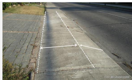
Foto 41: Especialmente en los accesos de vehículo que cruzan las veredas debe respetarse una pendiente transversal máxima de 2% en el ancho que corresponde a la ruta accesible.
