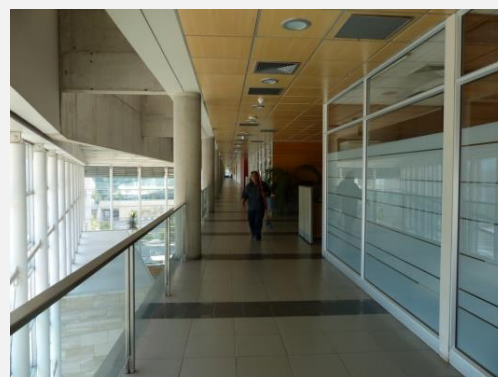
Foto 43: Pasillo que corresponde a la ruta accesible hacia recintos de atención a público.
