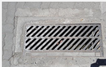
Foto 16 (izq): Rejillas puestas peligrosamente a favor de la circulación peatonal pudiendo causar atascos de las ruedas. Foto 17 (centro): El diseño de rejilla permite su instalación en cualquier sentido impidiendo el atasco de ruedas de una silla o coche. Foto 18 (der): Protección de taza de árbol correctamente enrasada y de color contrastante.
