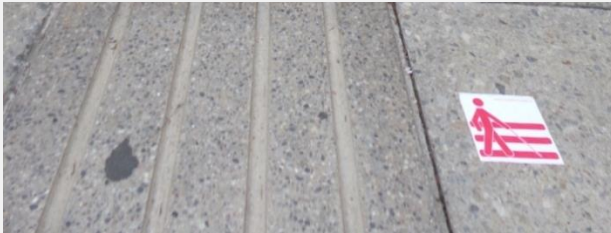
Foto 14 (izq) y 15 (der): El pavimento táctil bajo relieve presta una mejor función universal de circulación que el tradicional sobre relieve, incómodo para caminar sobre él, termina siendo evitado por los peatones provocando angostamiento del espacio útil de circulación.
