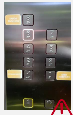
Foto 56: El Braille debe alinearse a un costado de los botones de números. En el caso de la fotografía, ubicado bajo cada número, se activarían todos los pisos al hacer lectura táctil de los botones.
