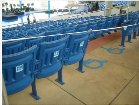
Fig. 90: No se puede interrumpir la línea de visión del espacio de permanencia por espectadores de pie ubicados adelante.
