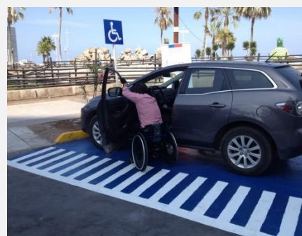
Fotos 31 y 32: Estacionamientos para PcD conectados a vereda o área de circulación
