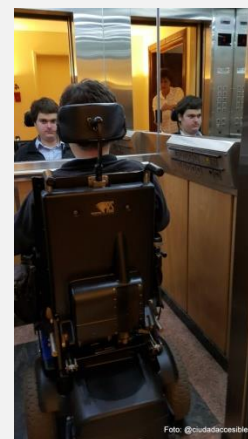
Foto 58: Ascensor con espejo ubicado sobre el pasamanos.
