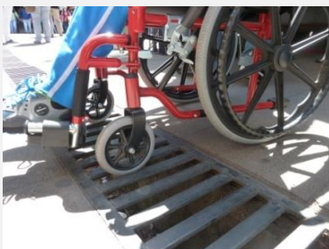
Foto 16 (izq): Rejillas puestas peligrosamente a favor de la circulación peatonal pudiendo causar atascos de las ruedas. Foto 17 (centro): El diseño de rejilla permite su instalación en cualquier sentido impidiendo el atasco de ruedas de una silla o coche. Foto 18 (der): Protección de taza de árbol correctamente enrasada y de color contrastante.
