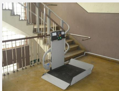
Foto 62 y 63: Modelos de plataformas elevadoras inclinadas para edificios existentes locales escolares, viviendas o edificios existentes destinados a servicios.
