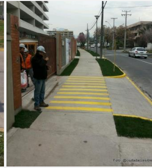
Foto 38 y 39: La ruta accesible se mantiene con preferencia sobre los vehículos demarcando la preferencia peatonal por sobre la vehicular.
