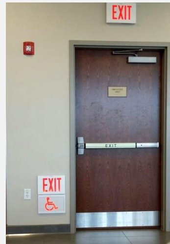
Foto 74: Puerta de escape considerada dentro de la ruta de evacuación accesible
