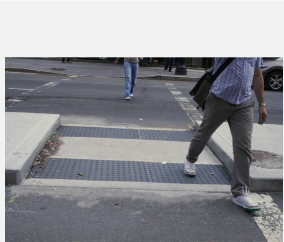
Fig 10: Mediana de ancho menor a 6 m que mantiene todo el ancho del cruce al nivel de la calzada. Foto 6: Mediana rebajada a nivel de la calzada con pavimento de alerta en el inicio y término de ésta.
