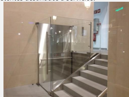
Foto 64 y 65: Modelos de plataformas elevadoras verticales para salvar desniveles en edificios existentes. Máximo 1,5m de desnivel.
