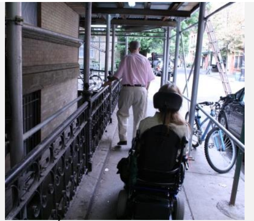
Foto 35: Área de circulación que mantiene condiciones accesibles durante los trabajos.
