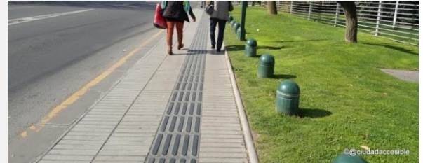
Foto 14 (izq) y 15 (der): El pavimento táctil bajo relieve presta una mejor función universal de circulación que el tradicional sobre relieve, incómodo para caminar sobre él, termina siendo evitado por los peatones provocando angostamiento del espacio útil de circulación.
