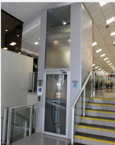
Foto 59, 60 y 61: Elevadores que parecen corresponder a los tipos de “especiales para personas con discapacidad” nombrados en la norma. Se desconocen mayores características técnicas para calificar los modelos que corresponden. Únicamente para ser instalados en locales escolares, viviendas o edificios existentes destinados a servicios.
