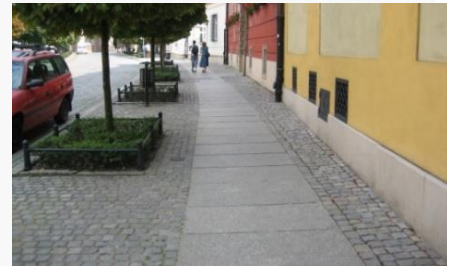
Foto 1: Ruta accesible en vereda, diferenciada en pavimento estable del resto de la acera de adoquines.
