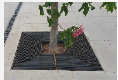
Foto 16 (izq): Rejillas puestas peligrosamente a favor de la circulación peatonal pudiendo causar atascos de las ruedas. Foto 17 (centro): El diseño de rejilla permite su instalación en cualquier sentido impidiendo el atasco de ruedas de una silla o coche. Foto 18 (der): Protección de taza de árbol correctamente enrasada y de color contrastante.
