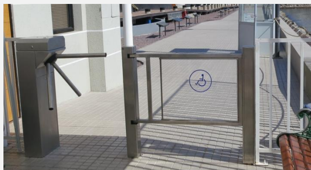
Foto 68 y 69: Control de acceso alternativo accesible a la entrada general por torniquetes.
