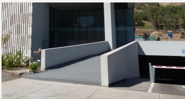
Foto 53 (izq): Los planos inclinados de pendiente igual o inferior a 5% están exentos de los requisitos de rampa. Foto 54 (der): Las rampas combinadas con escaleras deben responder a planos inclinados con pendientes igual o menor a 5% para evitar la obligación de pasamanos.
