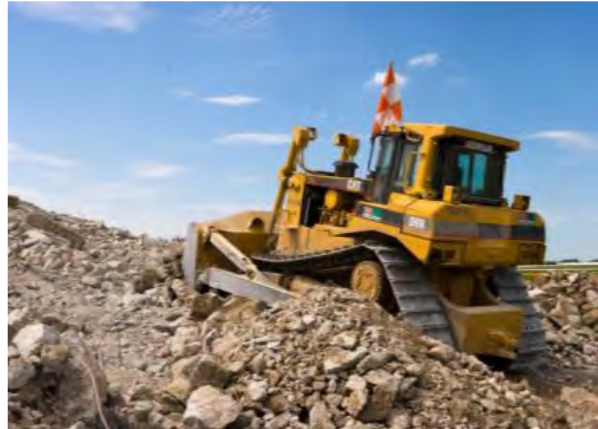
Acopio de hormigón de demolición . Foto: RSC, 2011.
