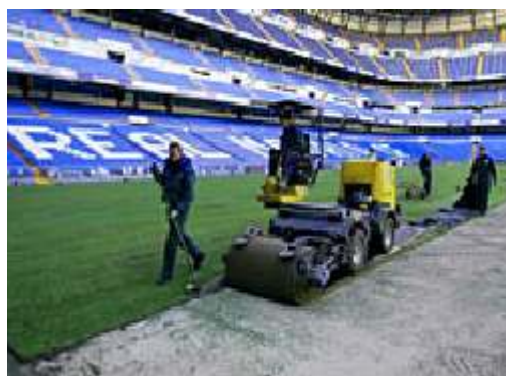
Figura Nº 18: Instalación carpeta sintética
