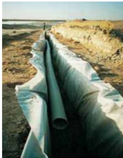
Figura N° 12: Zanja con geotextil.
