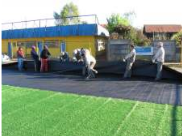
Figura N° 19: Tendido manual de rollos.
