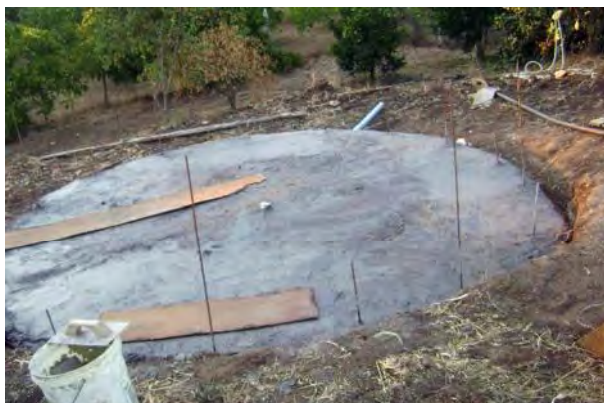
Figura 15. Base de la cisterna nivelada y construida con una mezcla de cemento, arena, agua e imper- meabilizante.
