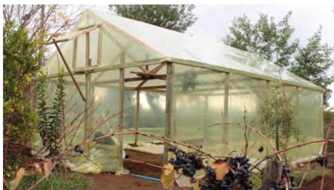
Figura 28. Invernadero con el plástico instalado.
