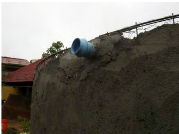
Figura 26. Detalle del rebalse ubicado en la parte superior de la cisterna.
