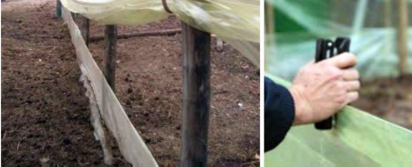
Figura 16. Instalación de bandas de proyección sobre alambre.
