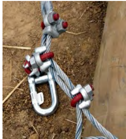
Figura 14. Uso de abrazaderas de sujeción del alambre acerado en los postes de la estructura.
