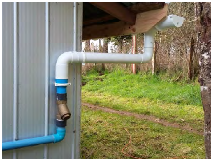
Figura 9. Filtro con cuerpo de bronce utilizado para retención de partículas pequeñas
