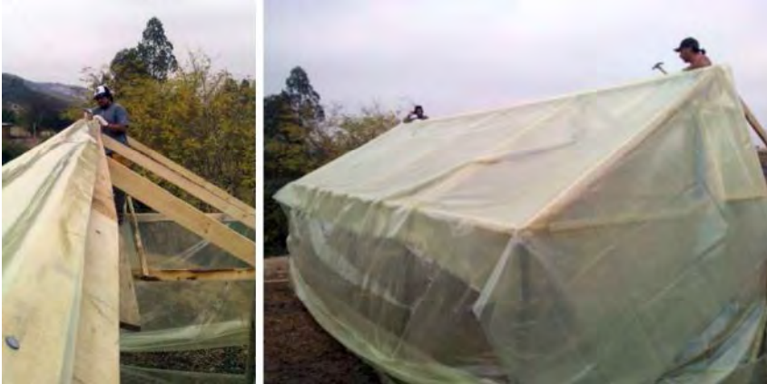
Figura 22. Fijación del polietileno a la estructura del invernadero.
