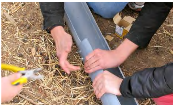
Figura 20. Unión de canaletas entre sí, para lograr la longitud requerida para la estructura "Atrapanieblas".
