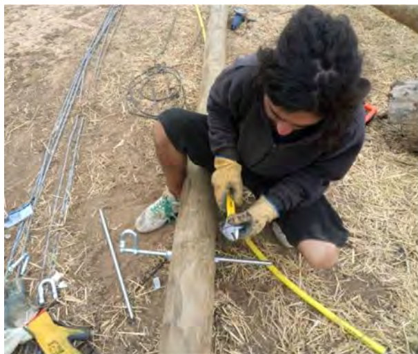
Figura 12. Postura de la varilla de anclaje en los postes de la estructura, y colocación de tuercas de seguridad.
