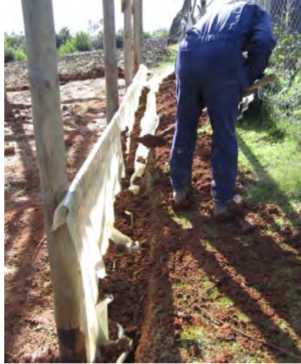
Figura 15. Instalación de bandas de protección sobre madera.
