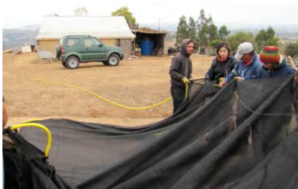
Figura 21. Preparación de la malla Raschel unida a la manguera y alambre acerado, previo a ser instalada entre los postes.
