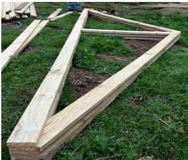
Figura 5. Construcción de cerchas centrales.
