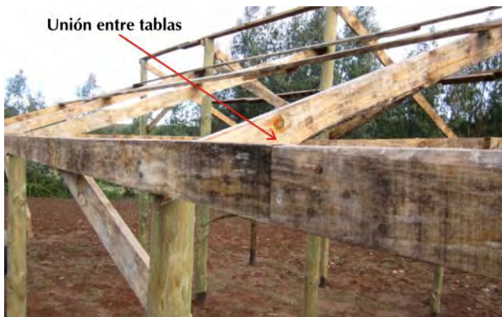
Figura 14. Unión entre tablas y terminación de cerchas interiores.
