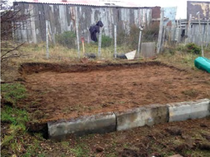
Figura 10. Nivelación de terreno para ubicación de cisterna flexible.
