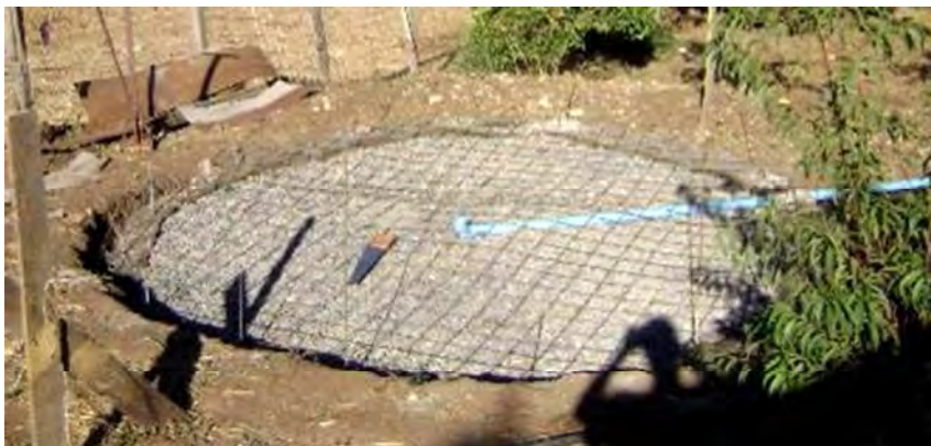
Figura 14. Instalación de la malla acma y la tubería de descarga.
