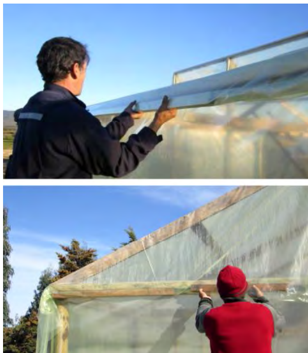
Figura 26. Fijación del plástico de la techumbre y los frentes superiores.
