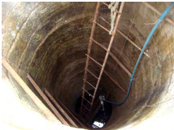
Figura 7. Pozo noria revestido con tubos de hormigón.
