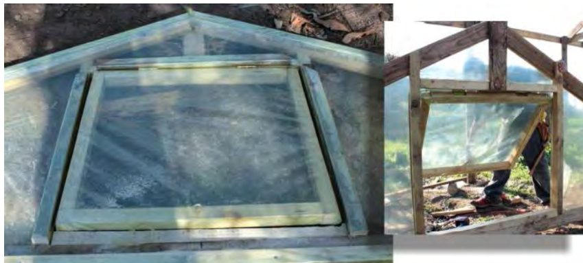
Figura 9. Detalle de la cercha frontal con la ventana de ventilación previamente instalada.
