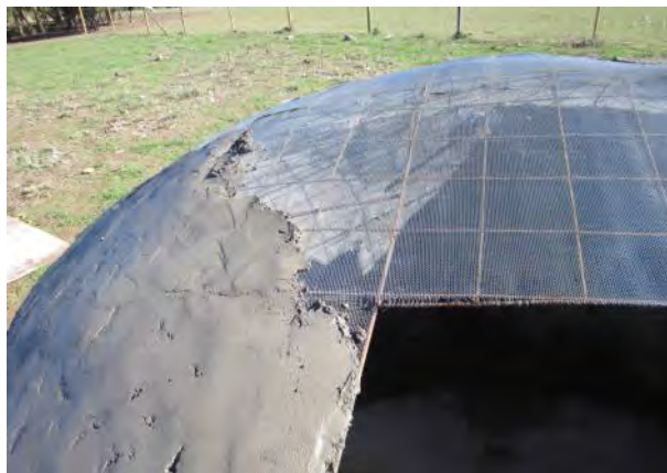
Figura 31. Revestimiento de la cubierta. Obsérvese, que este se inicia desde la parte inferior de ella, y se continúa hacia arriba.
