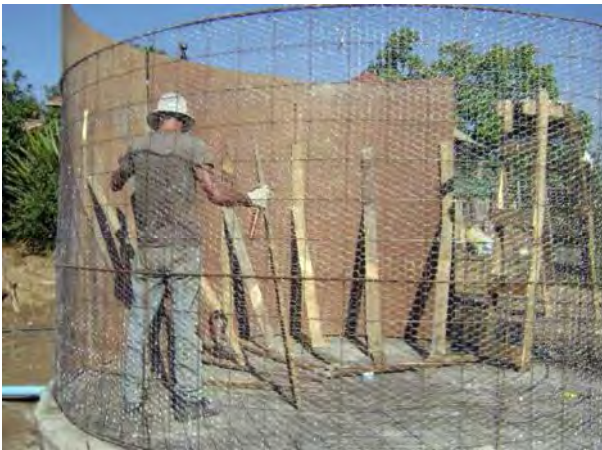
Figura 23. Instalación de la cimbra, para el revestimiento de la cisterna.
