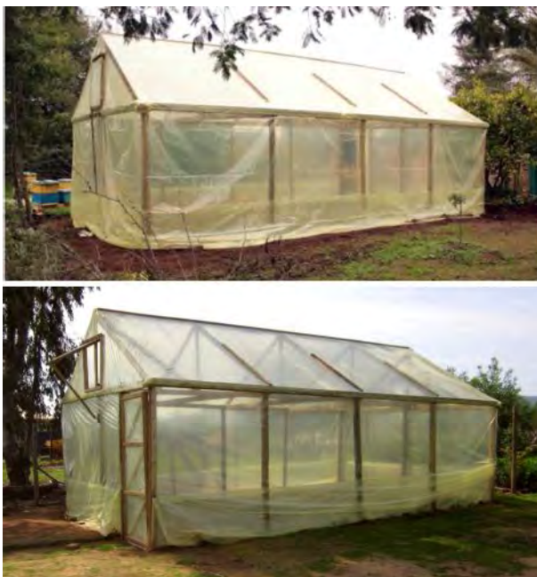
Figura 29. Instalación del polietileno a nivel de la techumbre.
