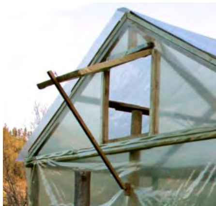
Figura 29. Instalación del polietileno a nivel de la techumbre.
