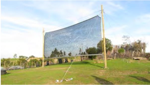
Figura 18. Sistema “atrapanieblas” y de aguas lluvias, de 40 m 2 de superficie de captación. La Aguada, comuna de Navidad. Región de O’Higgins.
