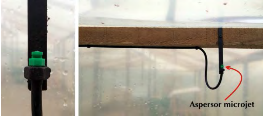
Figura 9. Imagen izquierda: sujeción de aspersor en tuerca tamaño 5/16"; Imagen derecha: vista de aspersor microjet para abanico de 180°, conectado a micro tubo de 4 mm.
