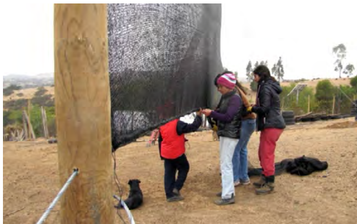
Figura 22. Labor de unión de la parte inferior de la malla Raschel, a la manguera y alambre acerado, envolviendo la manguera y asegurándola con aguja y pita.
