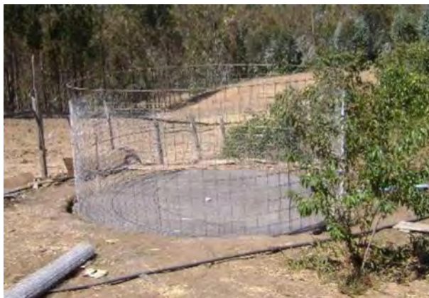
Figura 17. Estructura del cilindro, incorporando malla acma y malla de gallinero.
