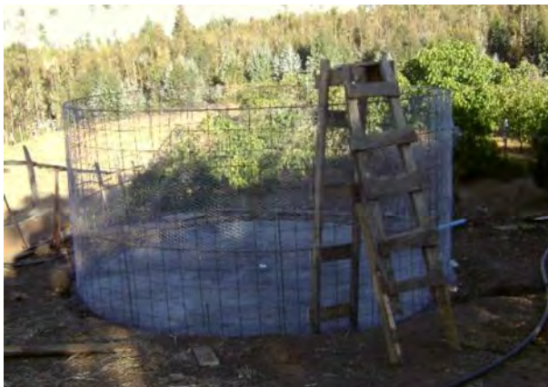
Figura 22. Estructura de la cisterna terminada, para el revestimiento con la mezcla de cemento, arena, y agua.
