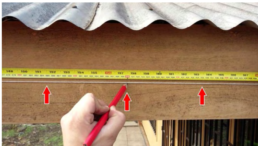
Figura 3. Marca para determinar la unión de canaletas y ubicación de ganchos cercanos a ella.
