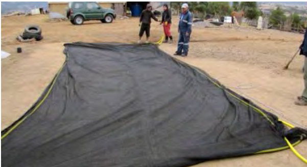
Figura 17. Malla Raschel preparada y sujeta a la manguera y alambre, previo a su instalación entre los postes de la estructura.
