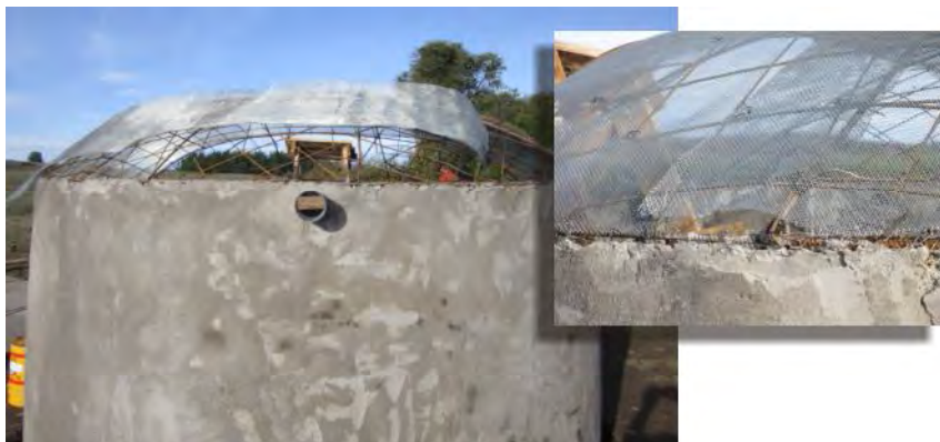
Figura 29. Detalle de la cubierta de la cisterna, con fierro y malla en su estructura
