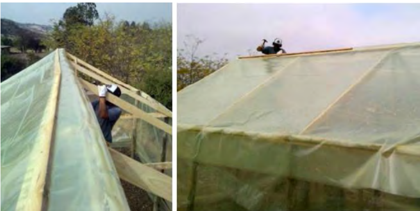
Figura 23. Detalle del montaje del plástico a la estructura.
