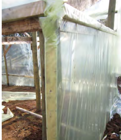
Figura 19. Sujeción del plástico en su parte lateral.
