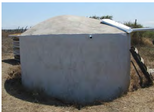
Figura 1. Cisterna de ferrocemento de 10.000 litros de capacidad.
