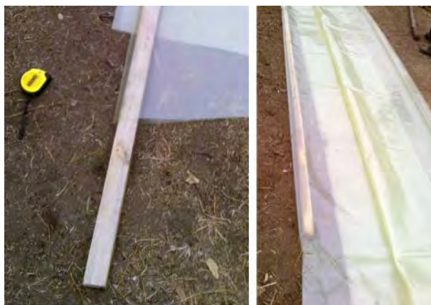
Figura 20. Preparación del polietileno para cubrir el techo.
