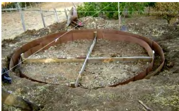
Figura 11. Excavación para la cimentación.
