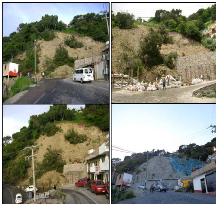
Deslizamiento Barrio de La Cadena, 2010., Fuente: Propia
