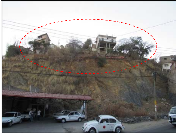
Deslizamiento Barrio Pedro Martin, 2016., Fuente: Propia
