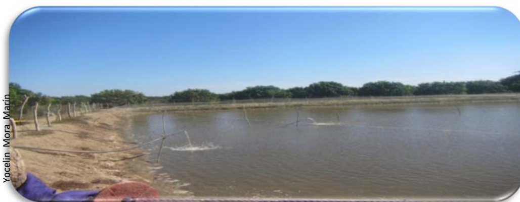
Figura 6. Estructura de estanque rustico. Copala, Guerrero. 2016.
