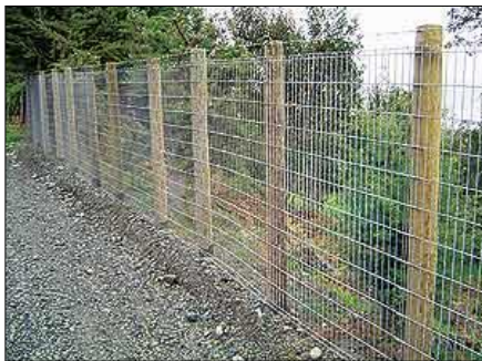
FIG 1.3. Mixto (Madera y Malla de Acero)
