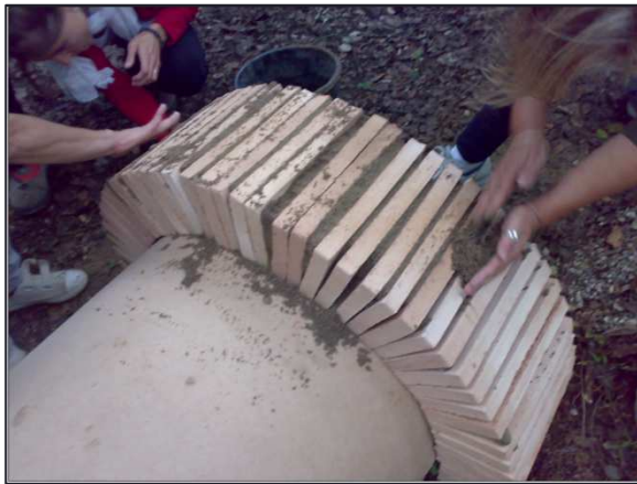
Foto 19. Arco de práctica con ladrillos sin usar cemento, sólo tierra y piedras.
