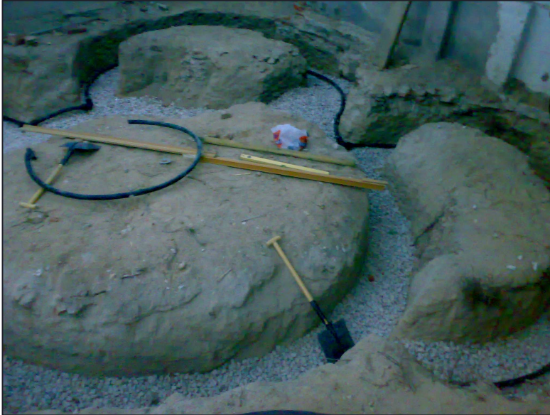
Foto 10. Colocación del tubo de drenaje en el exterior de la zanja de cimentación, en este caso hay ábsides por lo tanto hay que colocarlo siempre en el exterior del edificio.
