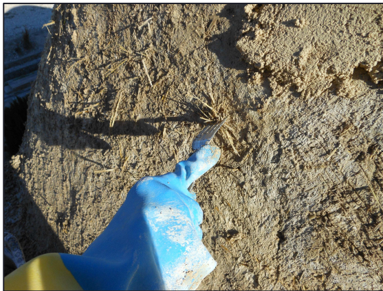
1ª capa de revoco con paja mezcla similar al Cob
