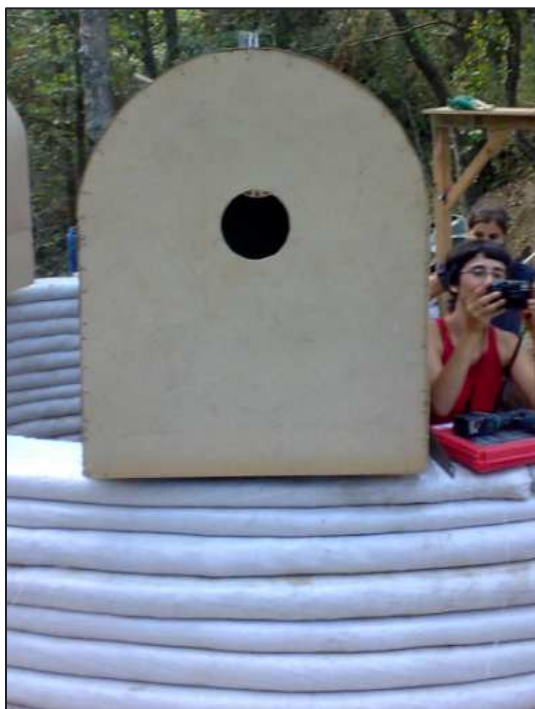
Foto20. Colocación del molde de ventanas y puerta.
