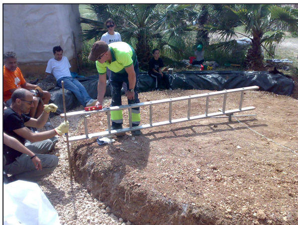
Foto 5: Medición mediante nivel de la profundidad de la cota de cimentación.
