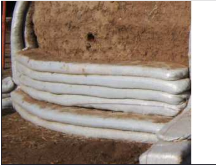
Fotografía 14. Finalización del contrafuerte
