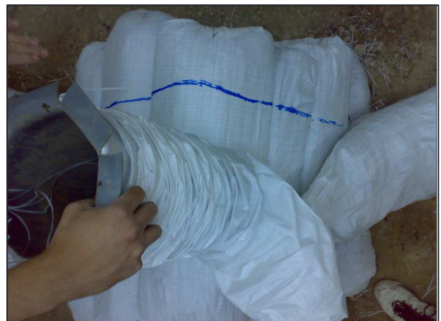
Foto23. Dibujar con el eje y un rotulador el ángulo de inclinación del domo, en el molde, ya sea en moldes de madera o de sacos.
