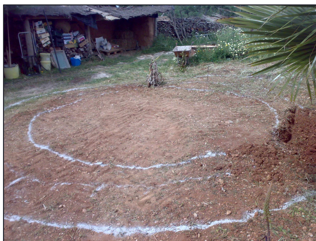
Foto 6: Representación de las dos tiradas y proceso de excavación
