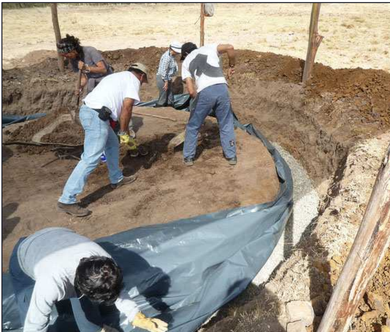
Foto 9: Colocación de aislamiento en todo el perímetro de la zanja
