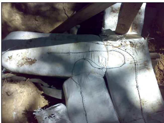
Fotografía 13. Unión con alambre espino al domo
