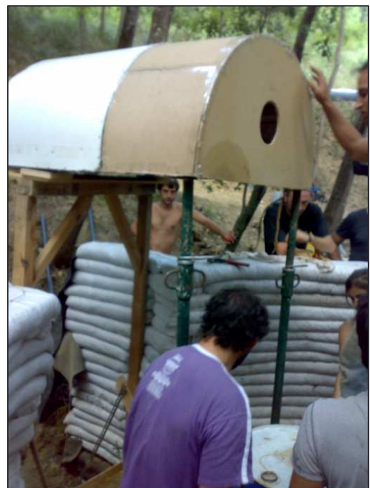
Foto20. Colocación del molde de ventanas y puerta.
