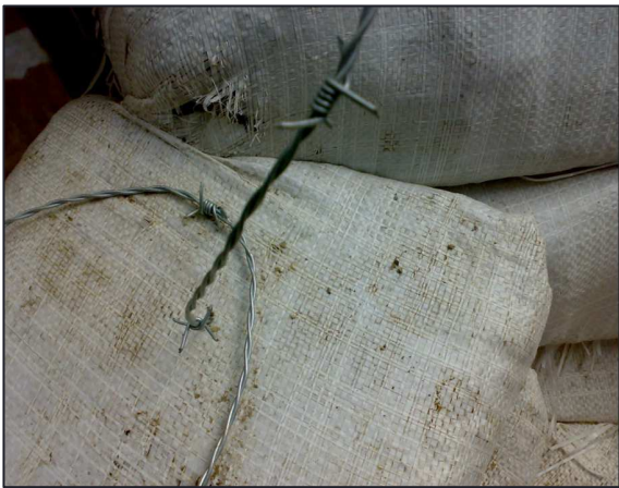
Foto 15. Importante en los contrafuertes. Cada tres tiradas un saco del contrafuerte llega hasta el final. Unir con alambre el contrafuerte
