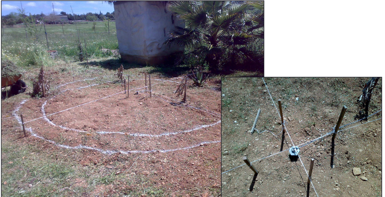
Foto 4: Colocación de ejes de referencia de la orientación solar. La foto fue realizada a otra hora de ahí que no coincida la sombra con los ejes.
