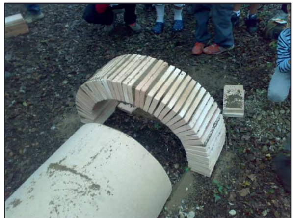
Foto 19. Arco de práctica con ladrillos sin usar cemento, sólo tierra y piedras.
