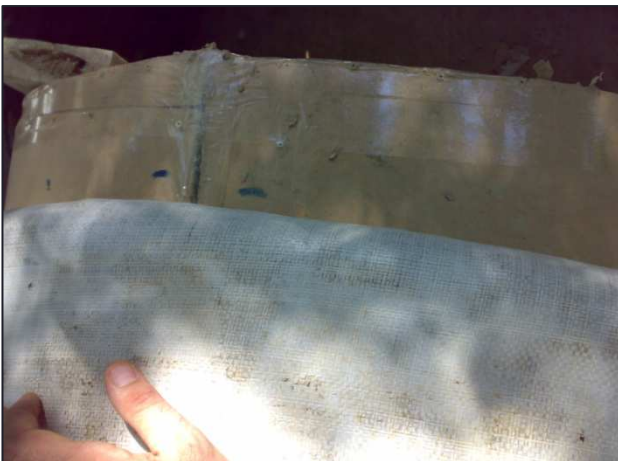
Foto23. Dibujar con el eje y un rotulador el ángulo de inclinación del domo, en el molde, ya sea en moldes de madera o de sacos.
