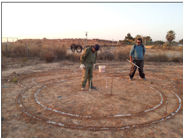
Foto 4: Colocación de ejes de referencia de la orientación solar. La foto fue realizada a otra hora de ahí que no coincida la sombra con los ejes.
