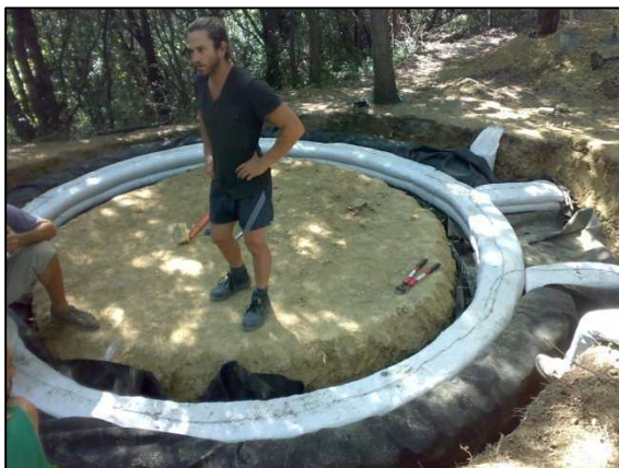
Foto 8. Finalización de la colocación de la tela butílica
