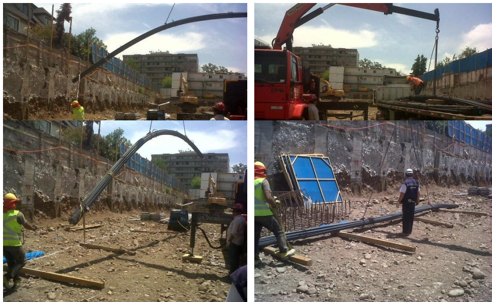
Figura N° 6: Procedimiento de descarga de acero en obra
