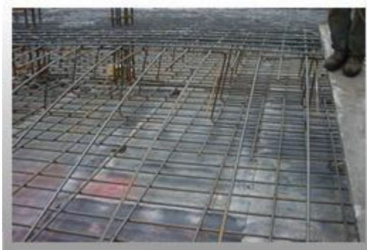
Fig. N°18 Membrana bentonítica bajo armadura.
