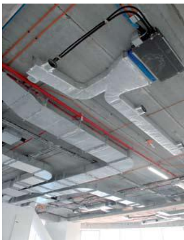
Fig. N°57 Instalación de los equipos de climatización y esquema del sistema VRV.
