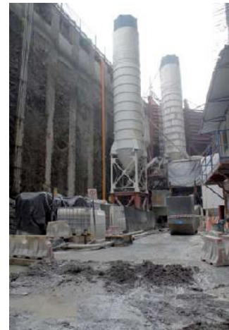
Fig. N°55 Planta hormigonera ubicada en el tercer subterráneo.
