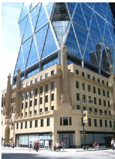
Fig. N°10 Rehabilitación de fachadas existentes de Hearst Tower.
