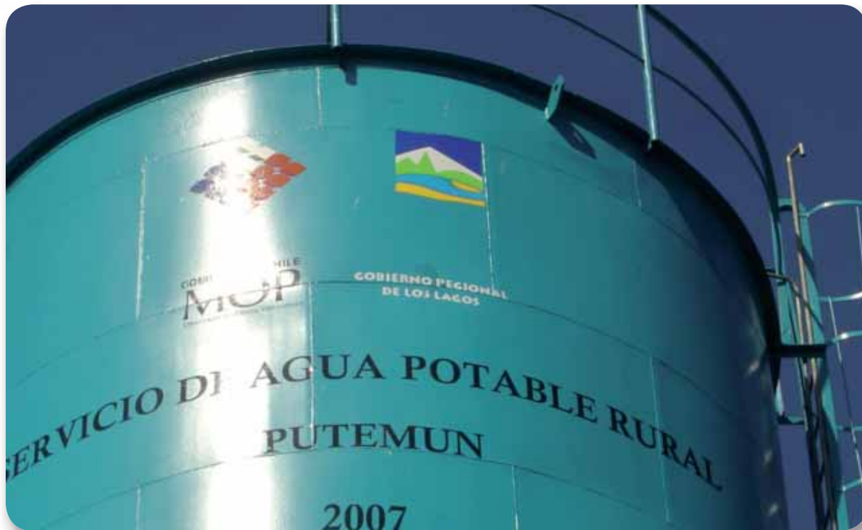
Instalación del Servicio de Agua Potable Rural Putemun. Castro, Región de Los Lagos.
