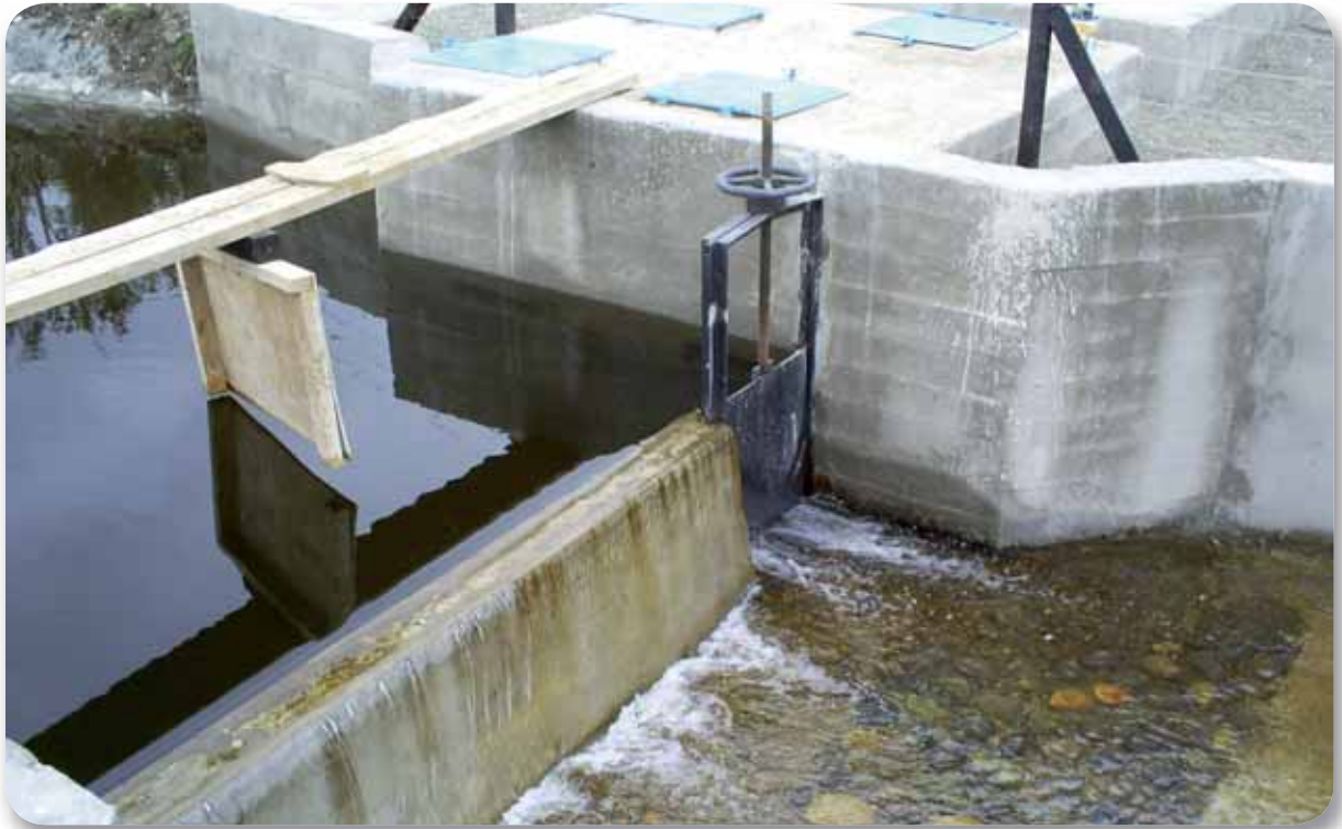
Instalación Sistema de Agua Potable Rural. Curanue, Región de Los Lagos.
