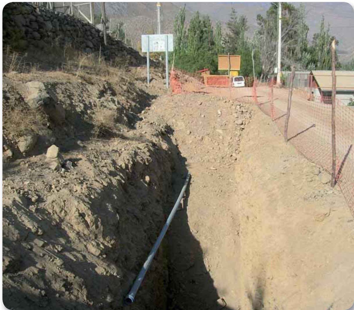
Construcción Sistema de Alcantarillado de Hurtado. Río Hurtado, Región de Coquimbo.
