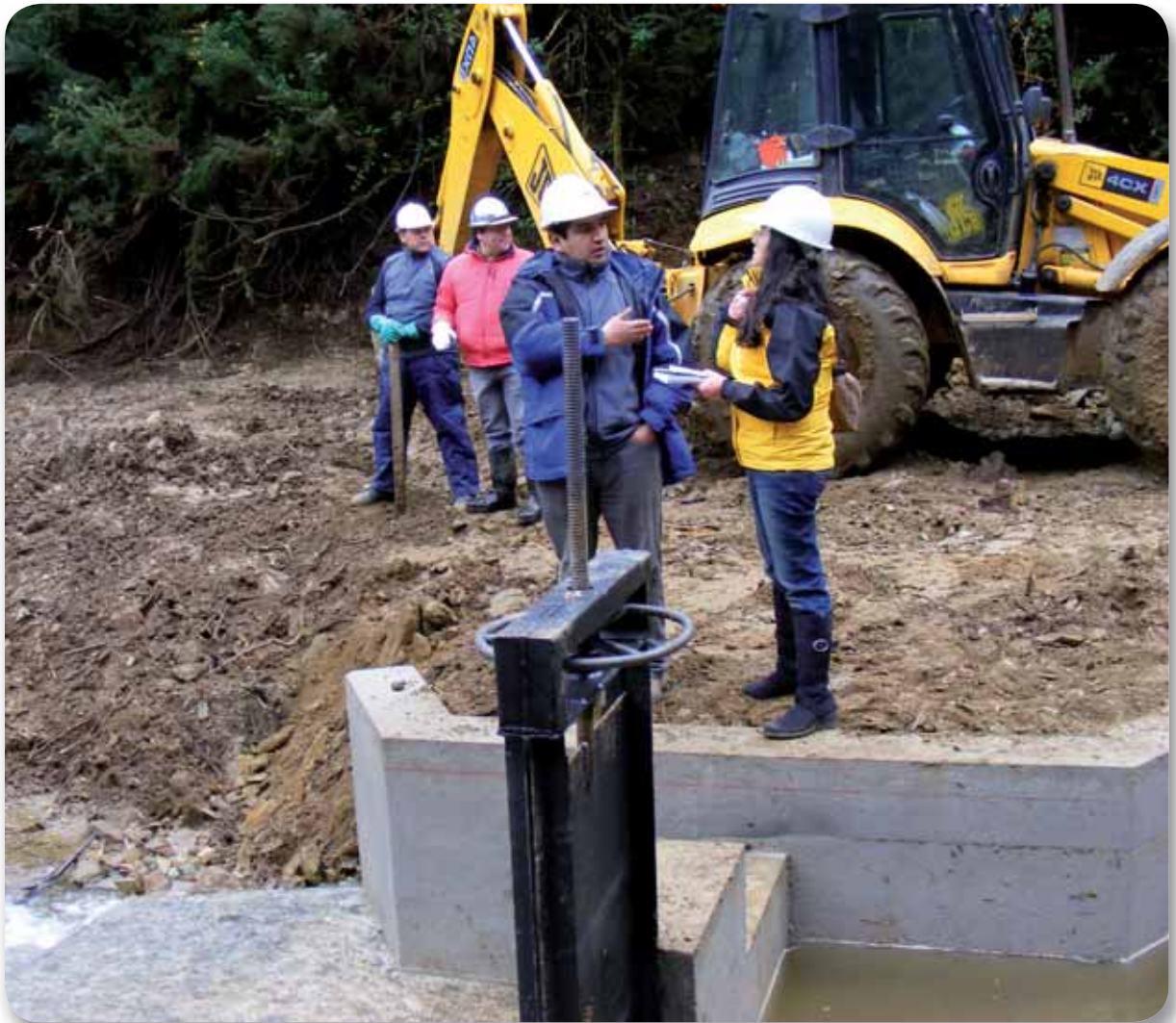
Inspección de Obras del Sistema de Agua Potable Rural en Isla de Rey. Corral, Región de Los Ríos.
