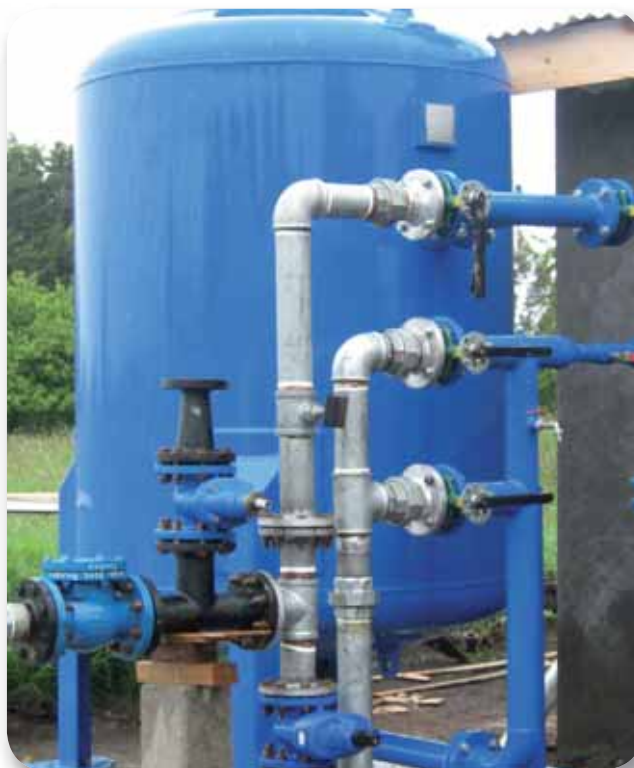
Instalación del Servicio de Agua Potable Rural Putemun. Castro, Región de Los Lagos.
