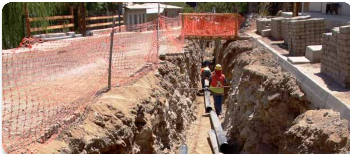
Construcción Sistema de Alcantarillado. Río Hurtado, Región de Coquimbo.
