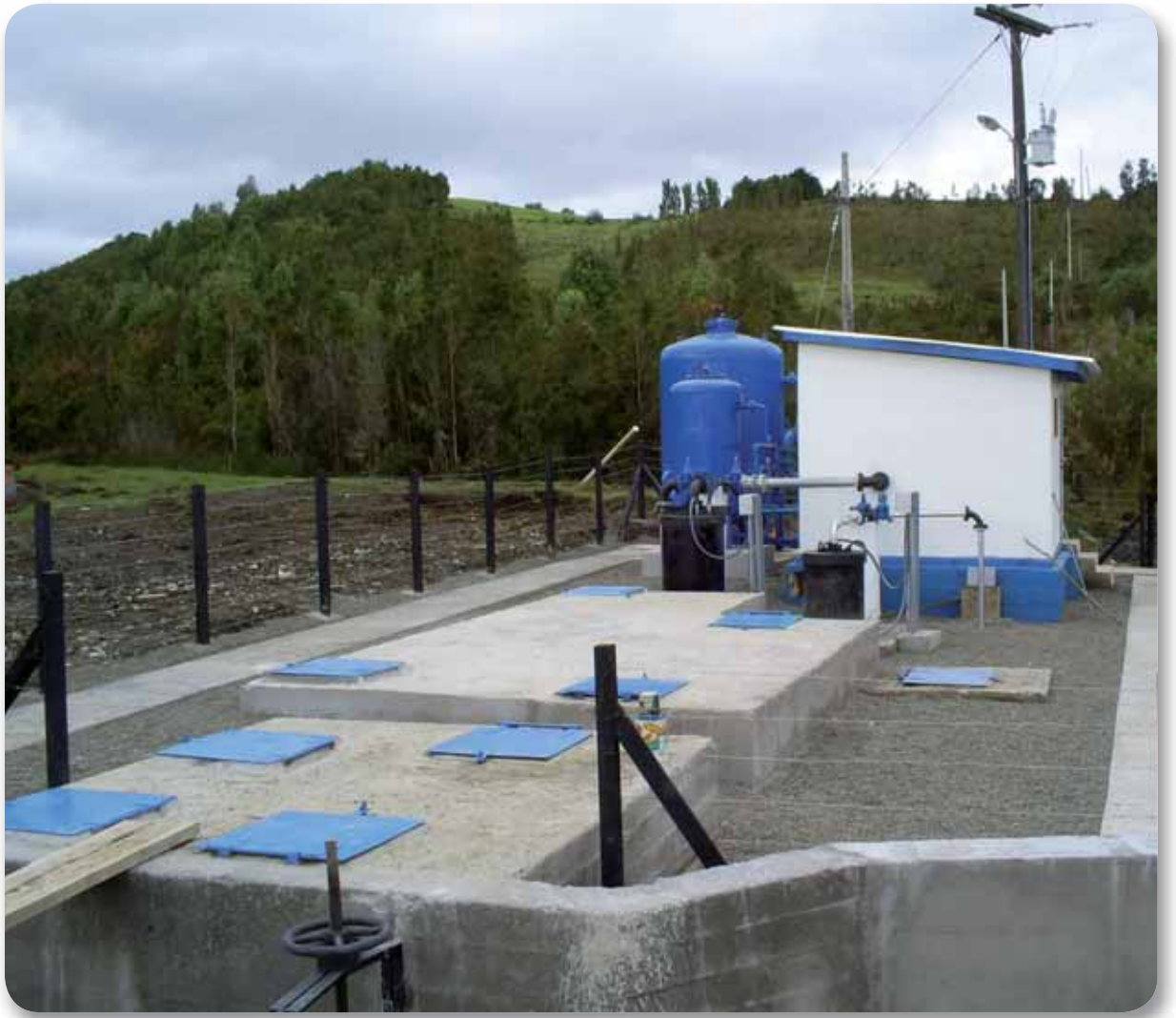
Instalación del Servicio de Agua Potable Rural. Curanue, Región de Los Lagos.
