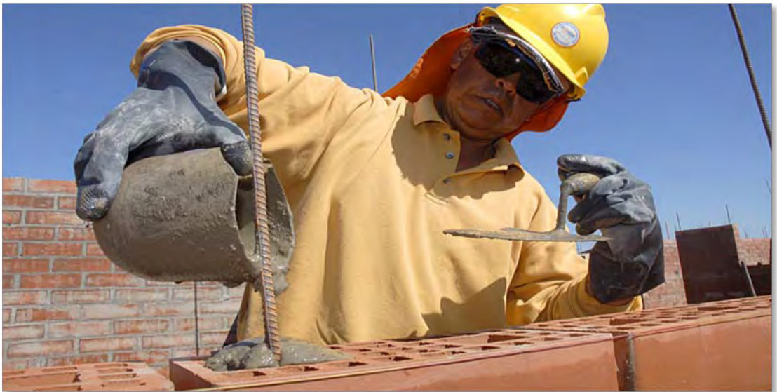
Fig.80.- Relleno de tensores.
