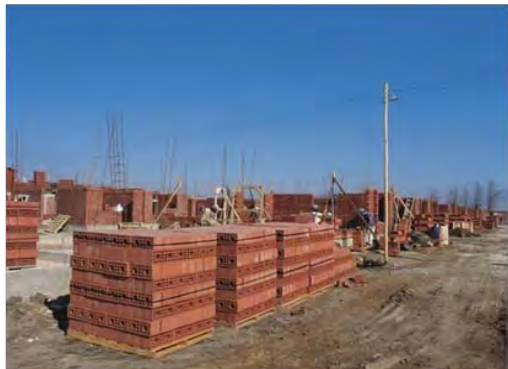
Fig. 50.- Pallets acopiados a pie de obra
