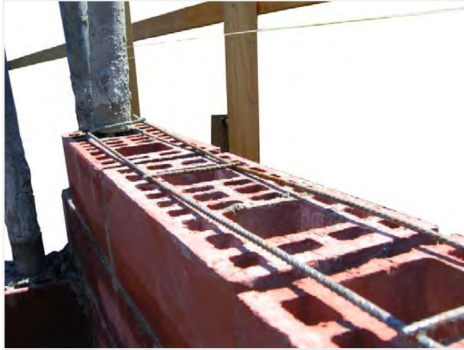
Fig.97.- Colocación de escalerillas.
