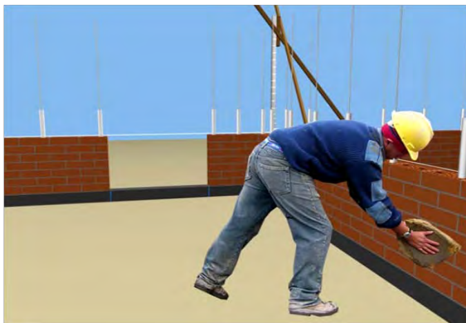
Fig.104.- Limpieza de muros.
