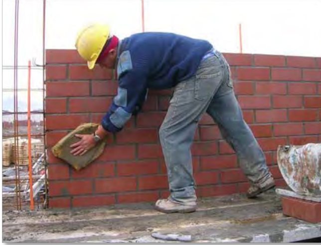
Fig.103.- Limpieza de muros.
