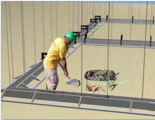
Fig.67.- Hormigonado de sobrecimiento.
