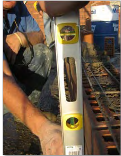
Fig.88.- Chequeo de verticalidad.
