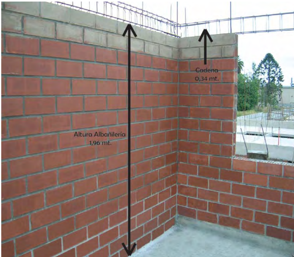
Fig.73.- Detalle de muro.
