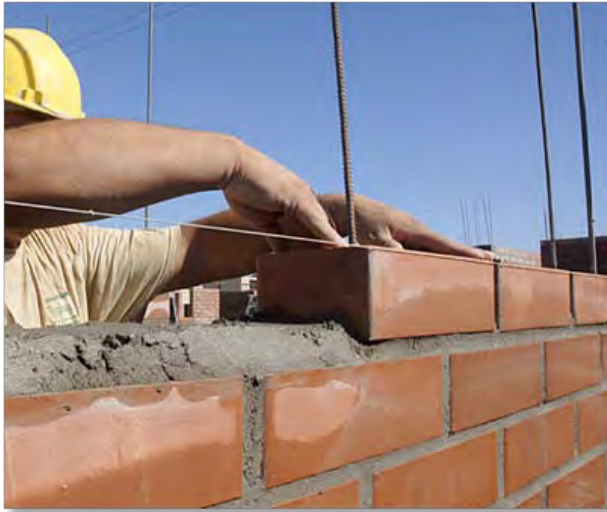
Fig.87.- Colocación de ladrillos alineado con lienza.
