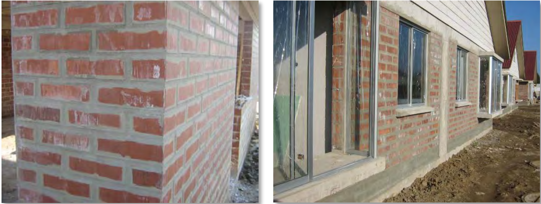
Fig. 105 y 106.- Muros impermeabilizados
