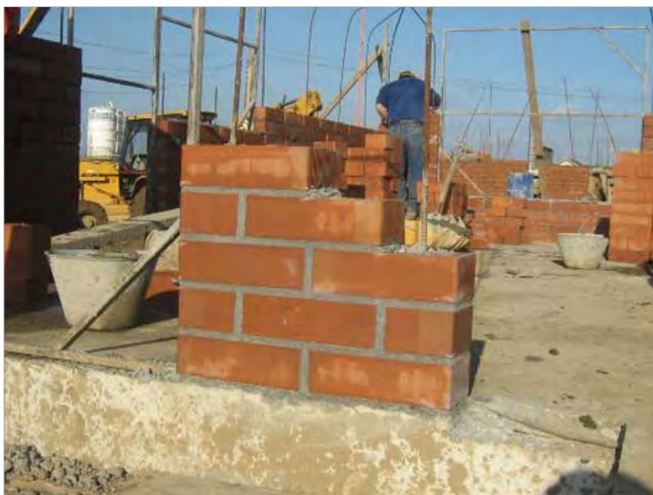
Fig.95.- Albañilería Escalonada.
