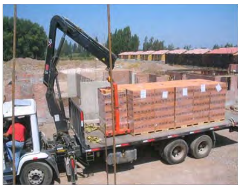
Fig. 52 y 53.- Descarga desde camión con pluma y descarga en obra con equipos horquilla / retroexcavadora con accesorio para pallets
