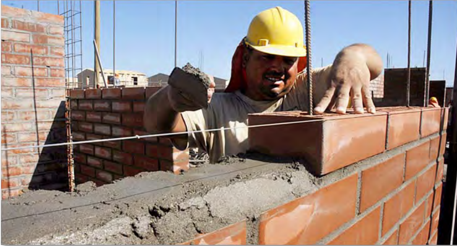
Fig.89.- Colocación de mortero.
