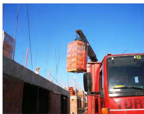
Fig. 52 y 53.- Descarga desde camión con pluma y descarga en obra con equipos horquilla / retroexcavadora con accesorio para pallets
