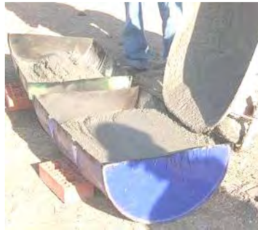
Fig. 23.- Batea de obra.
