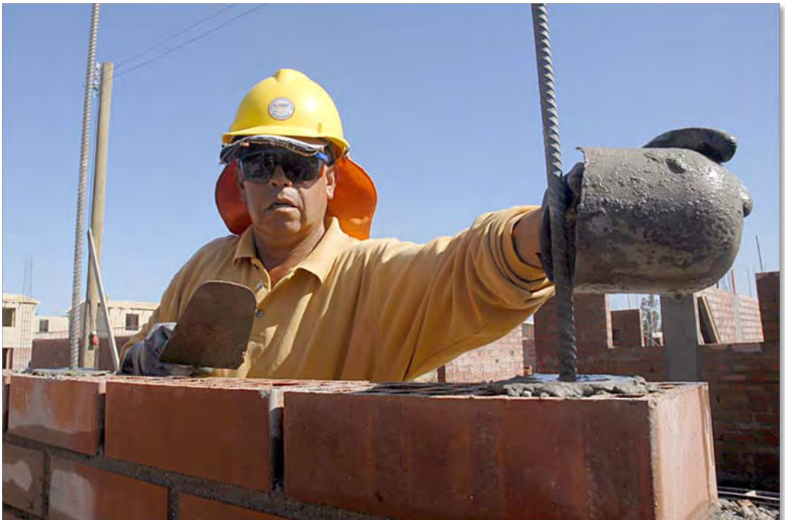
Fig.96.- Relleno de tensores.
