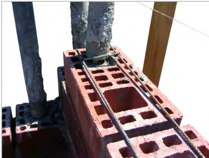
Fig. 72.- Detalle de regla con escantillón y lienza.
