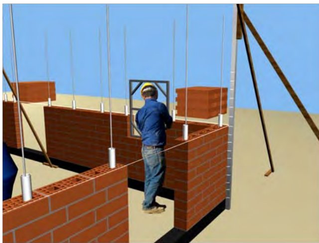
Fig.102.- Uso de premarcos de ventanas.
