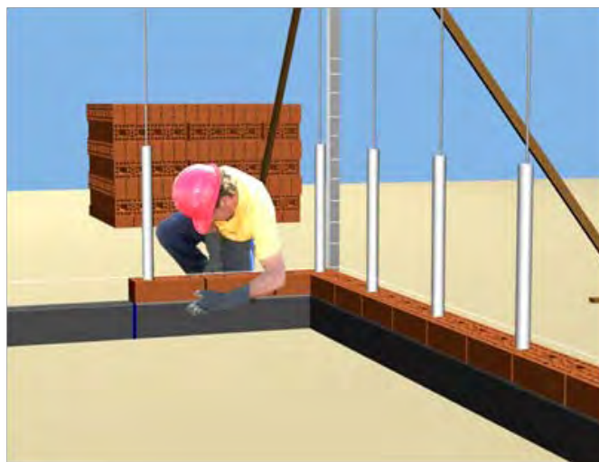
Fig.78 y 79.- Replanteo de primera hilada
