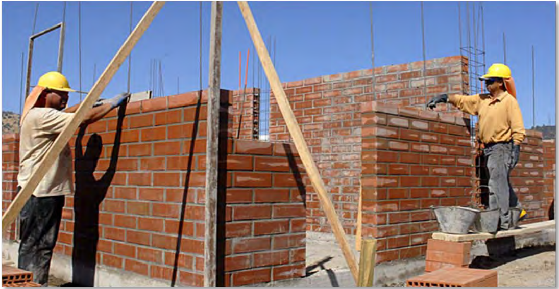
Fig. 55.- Albañiles en faena.
