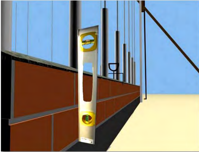
Fig.94.- Chequeo de verticalidad.
