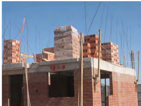
Fig. 51.- Pallets acopiados a pie de obra
