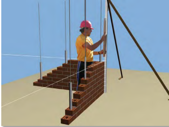
Fig.71.- Detalle de regla con escantillón y lienza.
