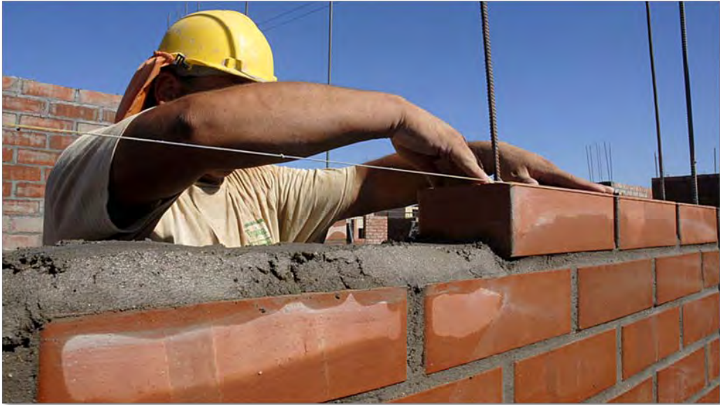
Fig.74.- Lienza marcando plomo exterior.
