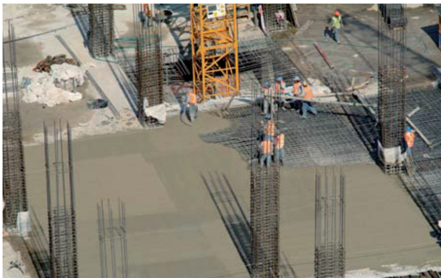
Hormigonado de elementos masivos con alta densidad de armaduras.
