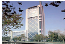
Edificio Corporativo CTC
