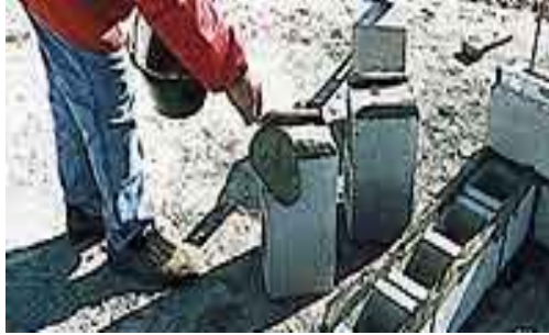
Figura 2.16: Colocación de bloques.
