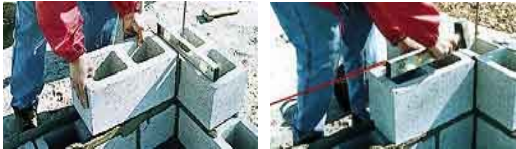
Figura 2.17: Colocación de bloques.
