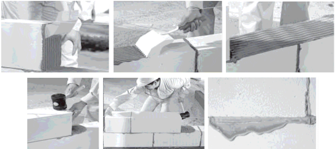
Figura 2.6: Aplicación Mortero Adhesivo.
