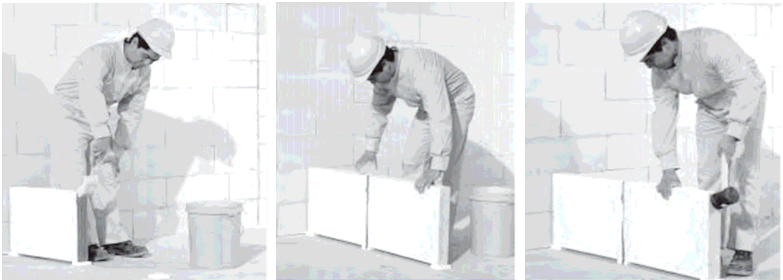
Figura 2.3: Colocación de la primera hilada.
