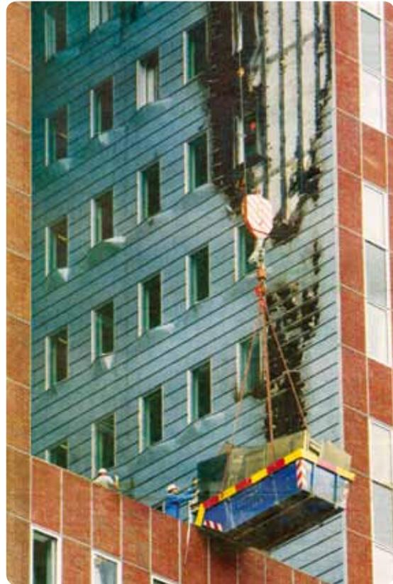
*Los detalles son importantes! A pesar de las advertencias por parte del constructor de la cubierta, eligieron la solución constructiva más barata. Resultado: la subestructura de madera causó un incendio.*
