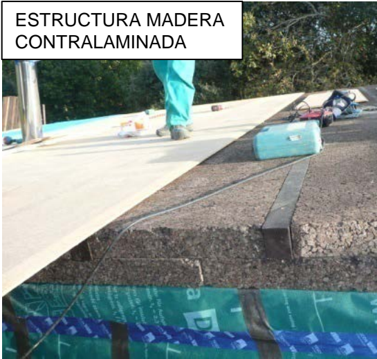
CASA ENTREENCINAS Cubierta inclinada U= 0,172 \text{ W/m}^2\text{K}
