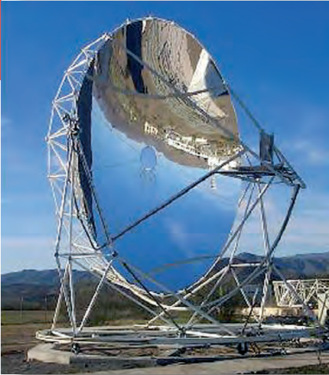
De entre las tecnologías que se emplean para convertir la radiación solar en electricidad, los sistemas cilindro parabólicos (debajo) y las centrales de torre (derecha) son los que han alcanzado mayor grado de madurez. A la izquierda, colector disco parabólico.
