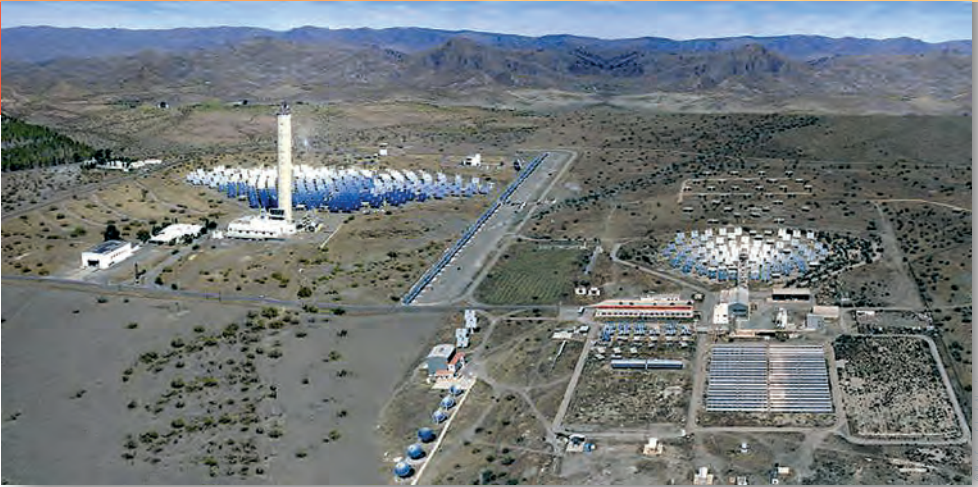
La Plataforma Solar de Almería (derecha), gestionada por el CIEMAT, es uno de los centros de investigación en energía solar más importantes del mundo. Sus avances han posibilitado la puesta en marcha de plantas como la PS 10, que se construye en Sevilla.
