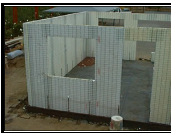
Foto 4 Estructura Paneles Covintec.
